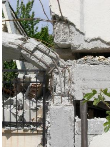
Danno D5- struttura in c.a. - «perdita» di un piano.
