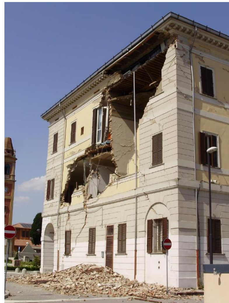
Danno D4/D5- estese fessurazioni a taglio con crolli parziali fuori dal piano
