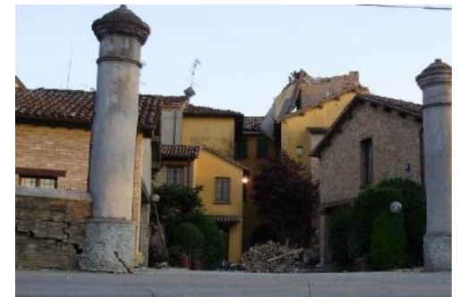
Rischio esterno su edifici e vie di accesso indotto dal campanile
