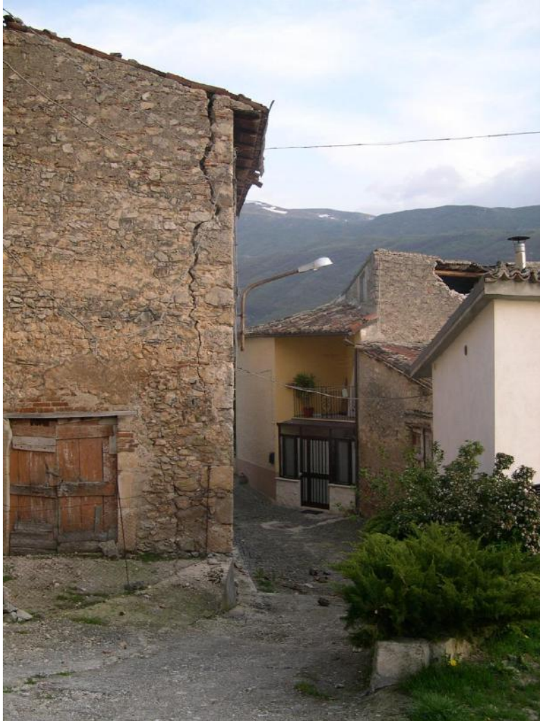
Danni D4/D5 –attivazione di cinematici di ribaltamento fuori dal piano
