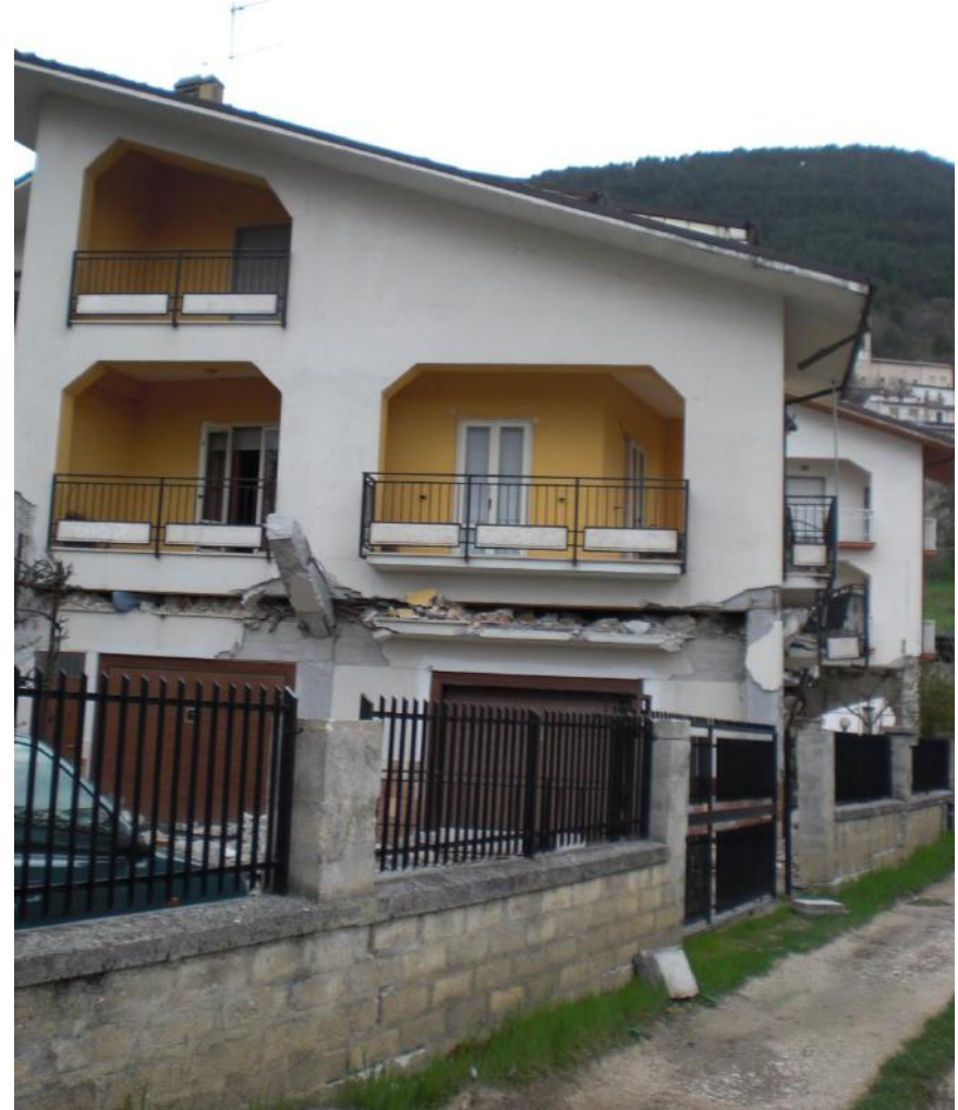
Danno D5- struttura in c.a. - «perdita» di un piano.
