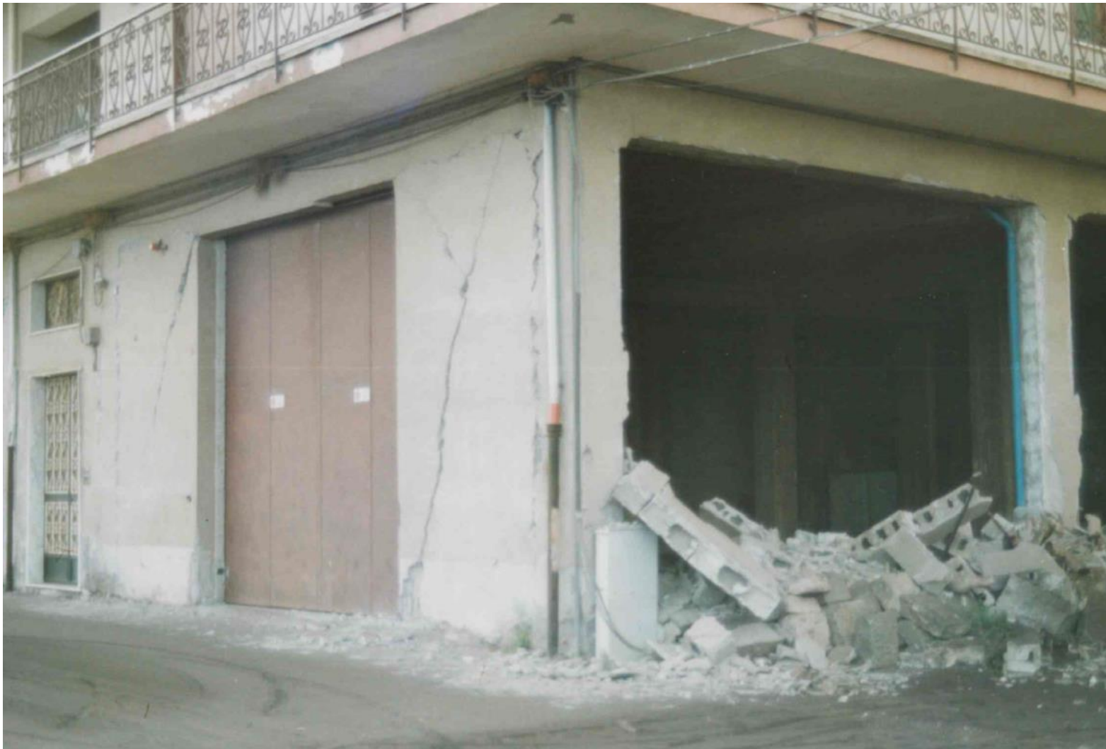
Danno D2/D3-telaio in c.a.
